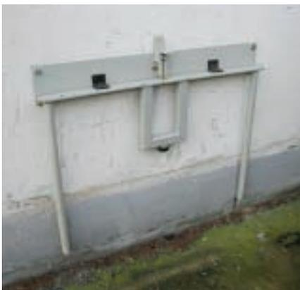
Um einen sicheren Zugang zu Dachflächen zu realisieren, entwickelten Mitarbeiter der Kingspan Gefinex GmbH, Pritzwalk, eine eigene Vorrichtung. Die in Eigenregie gefertigte Konstruktion ist fest installiert und umfasst einen um 90 Grad drehbaren Teil, der aus zwei Führungsschienen und einem Wandabstandshalter besteht.
