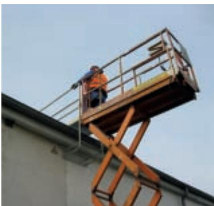
Der Wandabstandshalter verhindert ein Unterfahren des Dachzugangs und sichert außerdem einen ungefährlichen Abstand zwischen Hebebühne und Dachzugang. Damit wird ein sicherer Dachzugang für auf dem Dach erforderliche Wartungsarbeiten gewährleistet.
