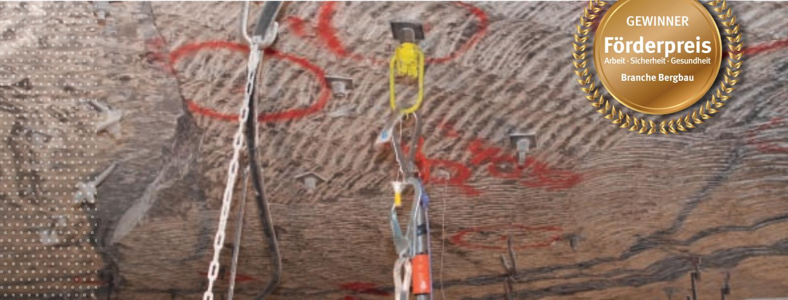
Im Kali- und Salzbergbau werden zur Sicherung der Grubenbaue Gebirgsanker eingesetzt. Diese werden in hoher Anzahl in die Firste eingebracht, um das Lösen und Herabfallen von Salzplatten zu verhindern.
