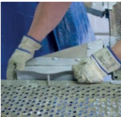
Abhilfe schaffen hier die von Siegfried Zipprick und Thomas Koll entwickelte Belagtraverse und Panzerbelagsicherung. Es handelt sich hierbei um einfach konstruierte Sicherungselemente aus Stahl, die man im Gerüstbau ohne zusätzlichen Aufwand einsetzen kann. Diese Sicherungselemente sorgen für eine formschlüssige und sichere Befestigung der Bodenelemente am Gerüst. Säulen, Träger oder andere vertikalen Elemente können nun frei von Stolperkanten und Lücken umbaut werden.
