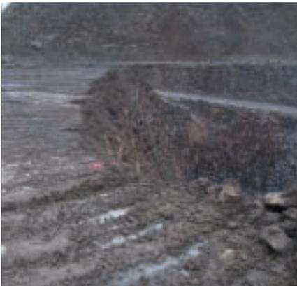
In der Vorbereitungsphase werden zunächst die Punkte markiert, an denen das fahrbare Bohrgerät die Sprenglöcher bohren soll. Nach dem Bohren werden die Löcher mit Sprengstoff besetzt und die Zündanlage installiert. Das Aufstellen von Gerüstelementen zwecks Absturzsicherung an der Kante wurde aus Zeit-, Kosten- und Flexibilitätsgründen nicht weiterverfolgt. Zur Sicherung der Absturzkanten bei der Bohrlochherstellung nutzt man stattdessen die vorhandenen Ressourcen aus.
