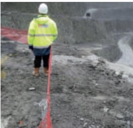
Da das Bohrgerät selbstständig von einem Bohrpunkt zum nächsten fährt, setzt man es zudem ein, um zwischen den eigentlichen Sprengbohrlöchern weitere, 0,5 Meter tiefe Löcher zu bohren. In diese Löcher werden Metallpfosten gesteckt und die Löcher mit Bohrklein verfüllt. Zwischen die Pfosten werden anschließend herkömmliche Baustellennetze gespannt.
