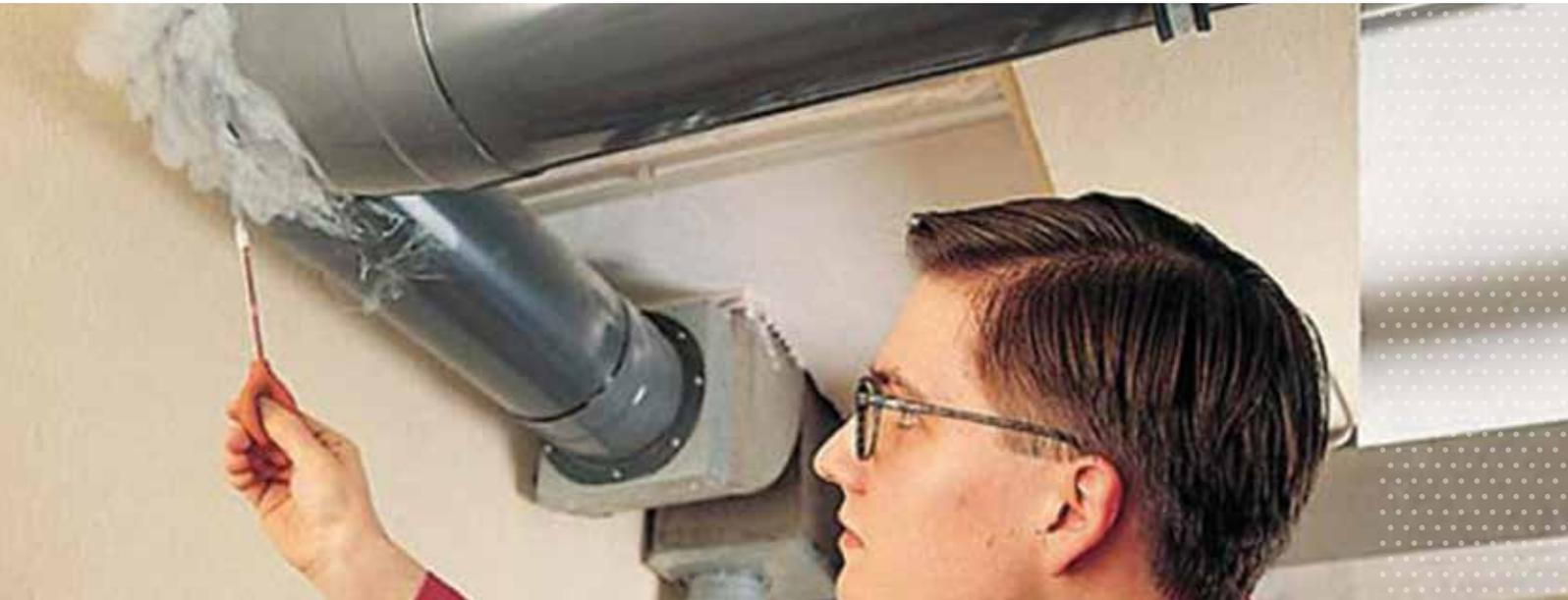
Bei vielen Tätigkeiten in Handwerk entstehen gesundheitsgefährdende Dämpfe und Stäube, die möglichst effektiv abgeleitet werden müssen. Häufig kommen lüftungstechnische Anlagen, vor allem Absaugungen, zum Einsatz. Oft zeigt sich, dass diese Anlagen nicht richtig dimensioniert, mangelhaft gewartet oder falsch positioniert sind. In Folge funktioniert die Absaugung nicht optimal und die Konzentration der Stoffe in der Atemluft wird nicht im gewünschten Umfang reduziert.
