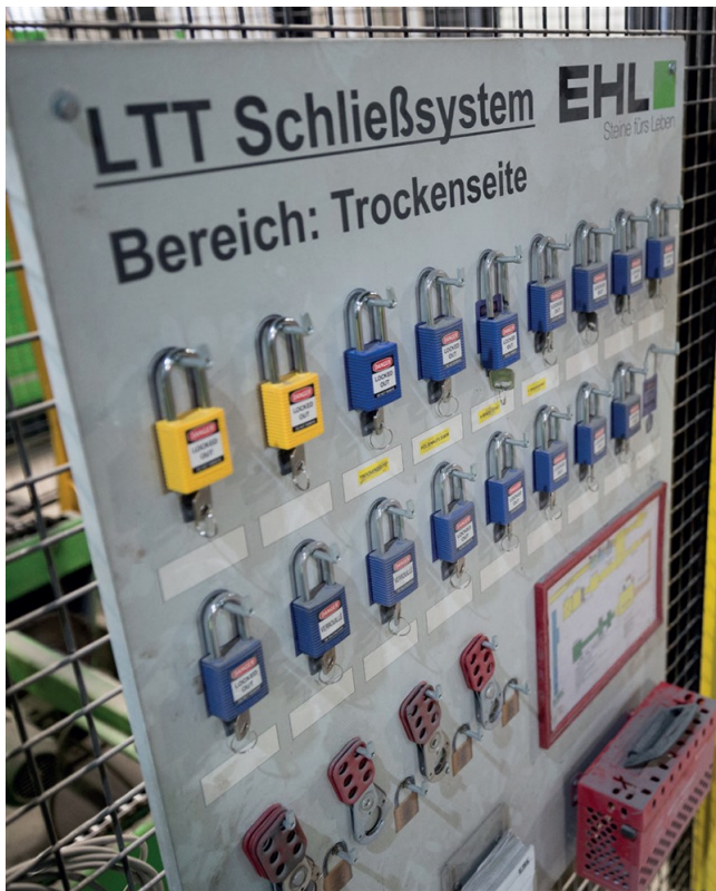
Konsequente Absicherung der Bereiche durch Schlösser.
