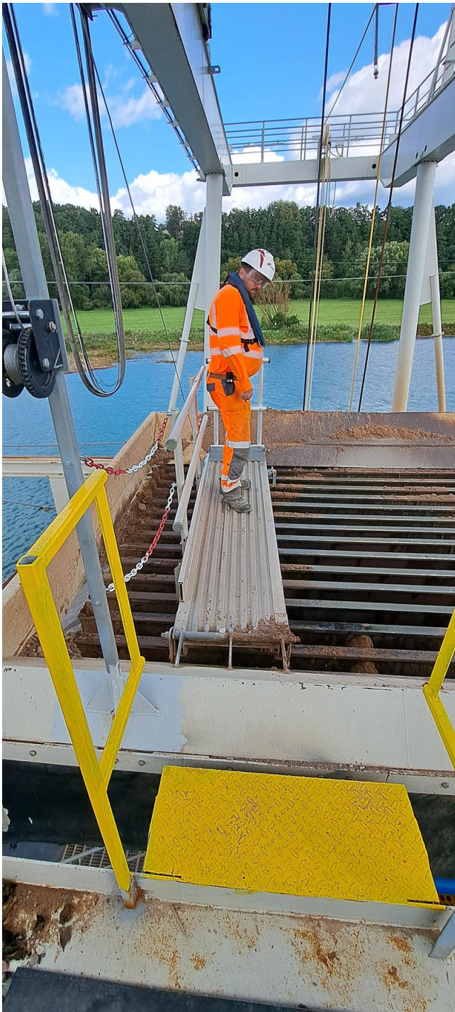
Zugang zur Arbeitsbühne
