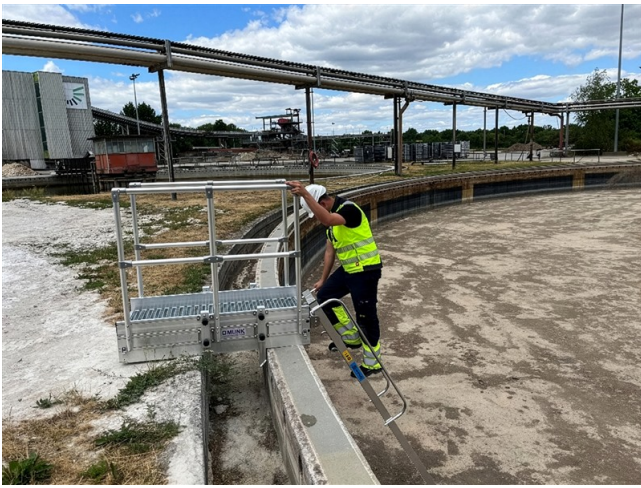
Sicherer Einstieg über das Podest und durch Einhängeleiter
