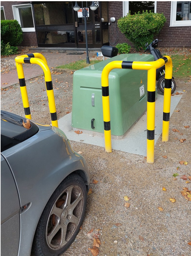
Ansicht der Brunnenanlage NACH der Umbaumaßnahme mit integriertem Anfahrschutz
