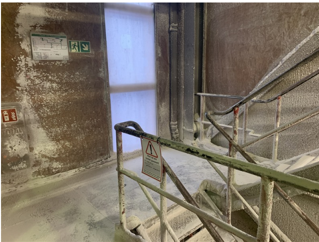
Unfallkarte am Unfallort im Fabrikgebäude
